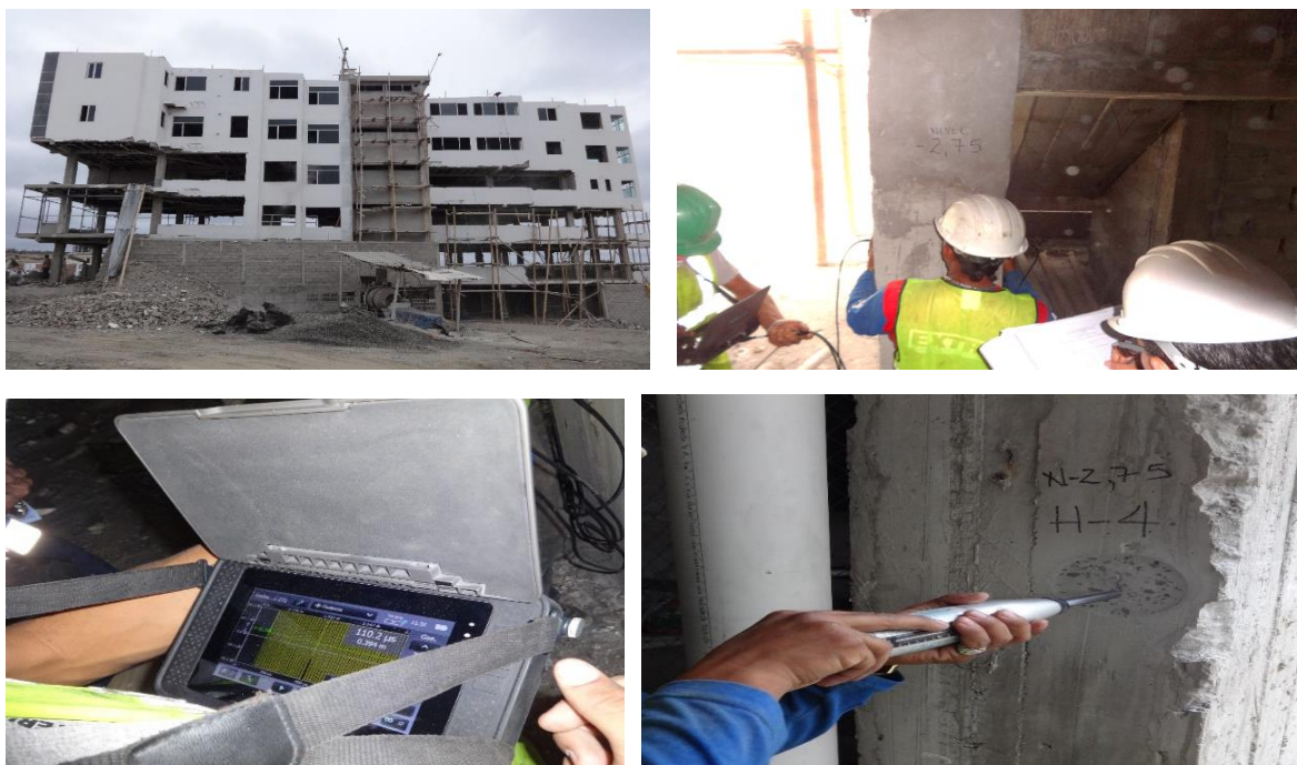
(Archivo de fotos de trabajos realizados, empresa INGEOMAT)
