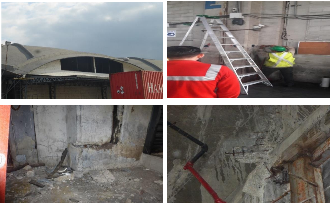
(Archivo de fotos de trabajos realizados, empresa INGEOMAT)
