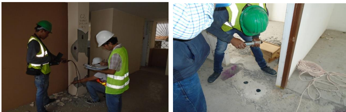
(Archivo de fotos de trabajos realizados, empresa INGEOMAT)
