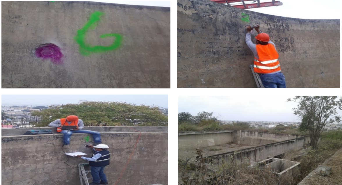
(Archivo de fotos de trabajos realizados, empresa INGEOMAT)
