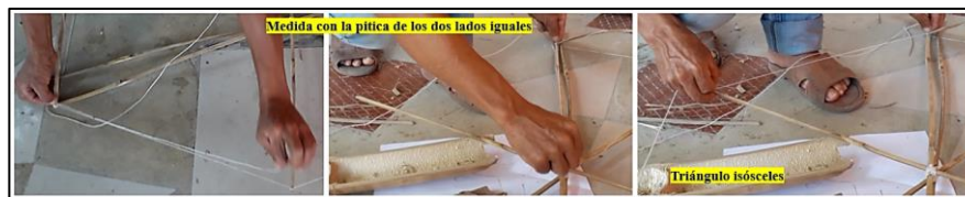
Figura 24 - Conformación de triángulos isósceles medidos con la pita.
